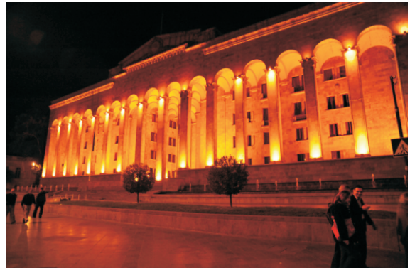
Gürcistan Parlamento Binası (2012)
