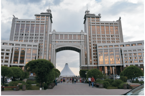
Kaz Munay Gaz binası (2016)
